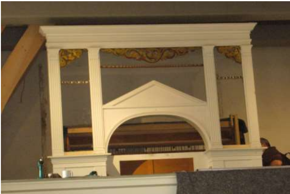
Orgel-Vorderwand aufgebaut und Trakturteile eingebaut
